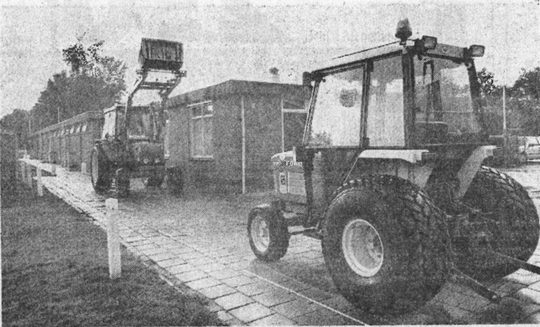
● De komende tijd een vertrouwd gezicht: bouwwerkzaamheden op het terrein van voetbalclub Deto. De Vriezenveense zaterdag-amateurs willen met een eigentijdse accommodatie de volgende eeuw in.
